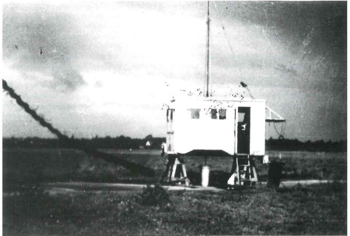
(38) Das Peilerhaus in den fünfziger Jahren.
