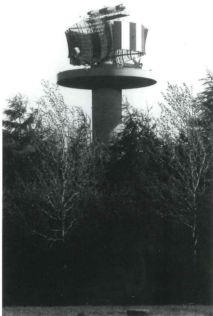
(28) Mittelbereichs Rundsicht radaranlage in Boostedt vom Typ SRE-LL 1.
