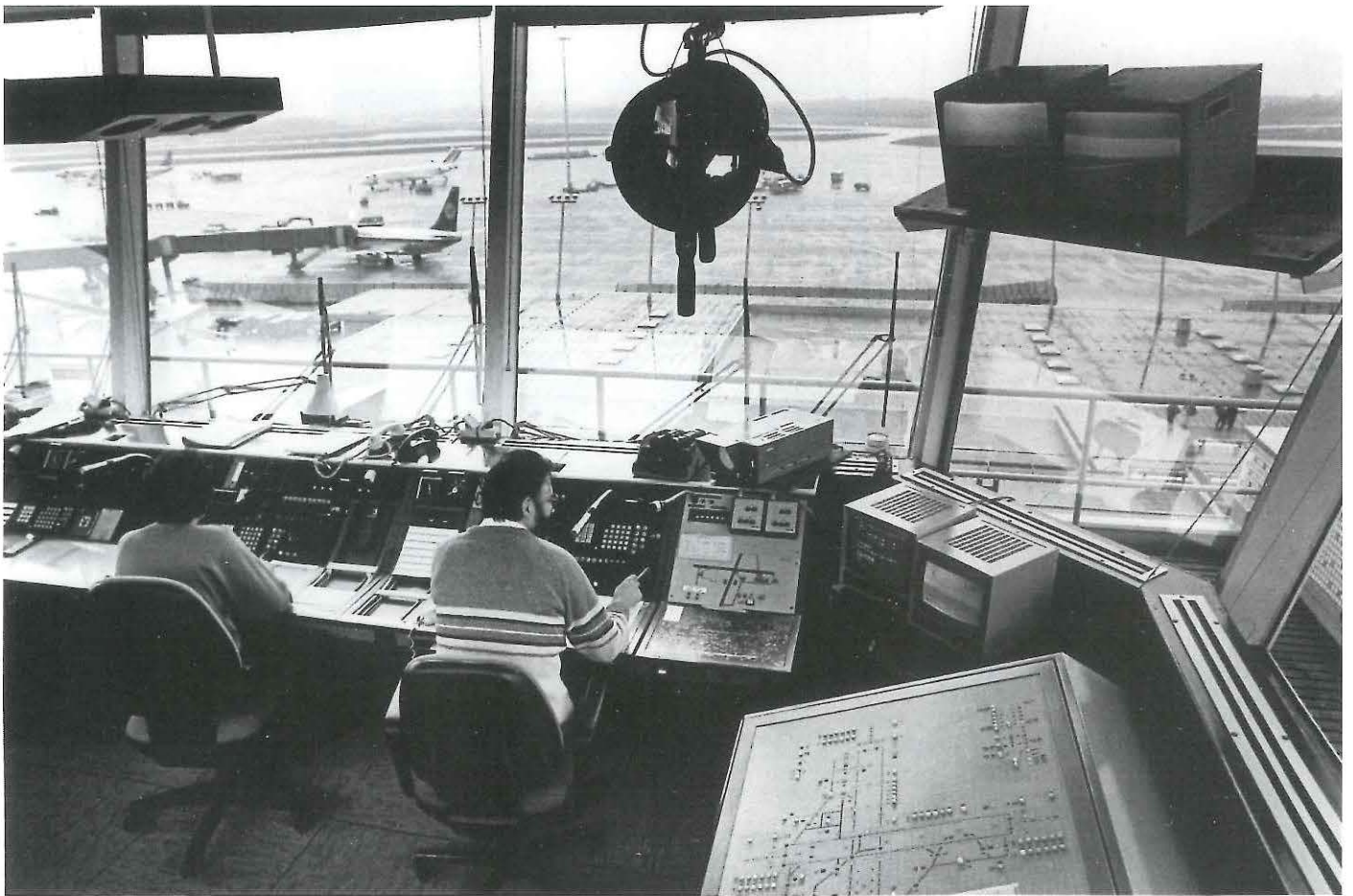
(9) Auf dieser Aufnahme von allen Tower sind allerlei technische Antiquitäten zu erkennen: links oben die Deckenlautsprecherboxen verschiedener Sprechfunk-Frequenzen, in der Mitte oben die sogenannte „light gun“ für Lichtsignale an Flugzeuge ohne Funkgerät, rechts oben die Monitore zur Überwachung des nicht einseharen Pistenanfangs 16, rechts vom Tower-Lotsen das Schaltbrett für das Stopbarren-System, ganz rechts das Lichtschaltpult für die Flugplatzbefehrerung.
