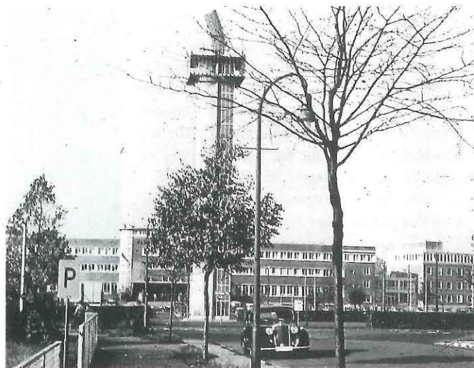
(29) Der alte Radarturm auf dem Paul-Bäume-Platz mit ASR-3-Antenne.
