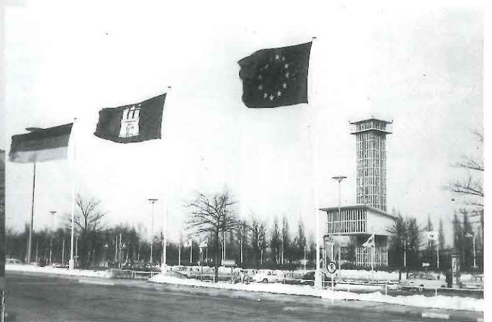
(33) 1969 wurde die Antenne schon demontiert. Schließlich wurde auch der Turm abgerissen.
