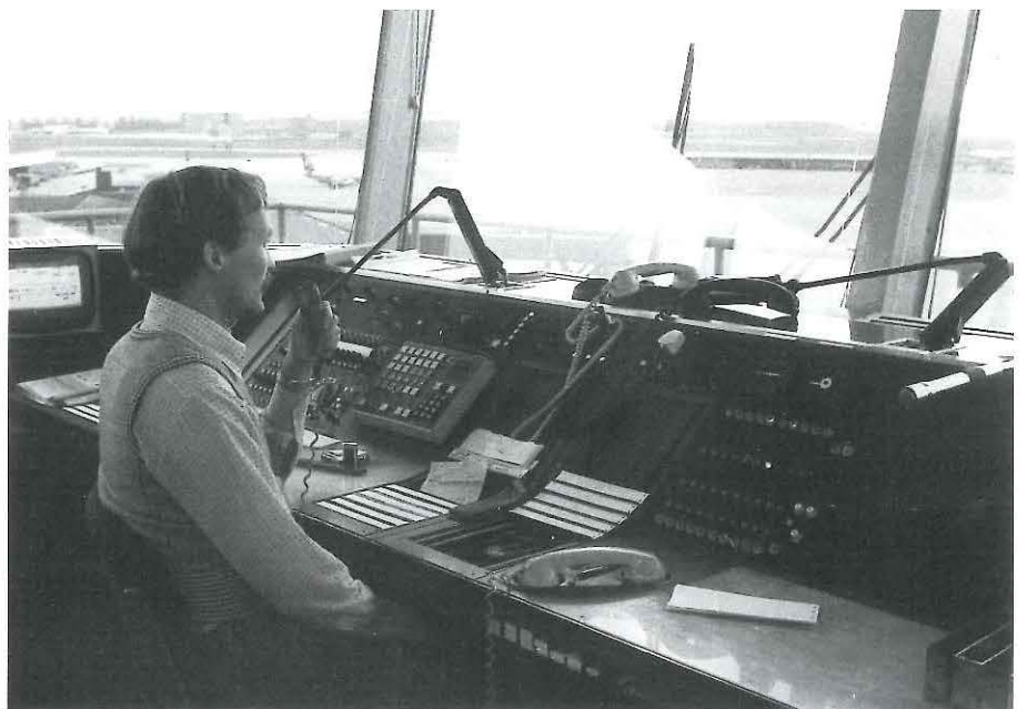
(7) Flight-Data-Assistant und Tower-Controller. Als Hilfsmittel hatte der Tower-Lotse direkt vor sich das Anzeigerät des Funkpeilers (VDF) und zu seiner Rechten das Mini-Radar (DFTI).
