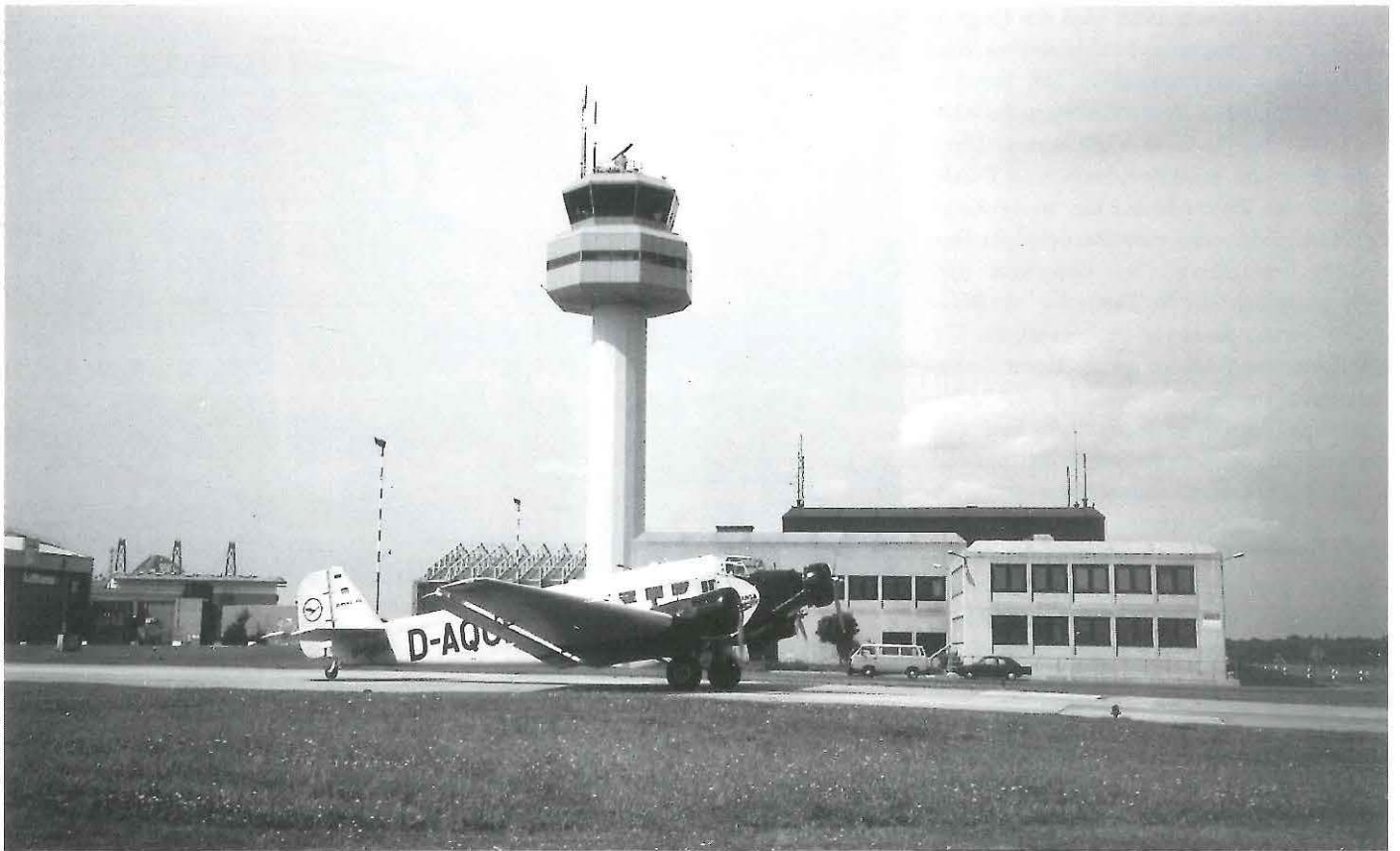
(14) Die Ju52 vor dem neuen Flugsicherungsgebäude, 1998.
